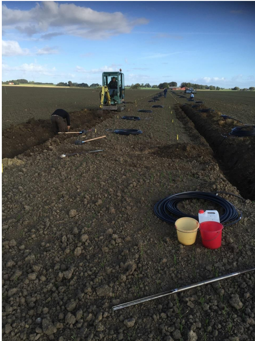
Foto 3. Etablering af sugecelle arealet. Cellerne monteres i bunden af de gravede render. Slangerne føres ud af forsøgsparcerne via slanger der nedgraves i slange tracéer der etableres i skellet mellem forsøgsparcerne. Se også foto 1. Foto: Ove Edlefsen, Juulsgaard Tensiometre
